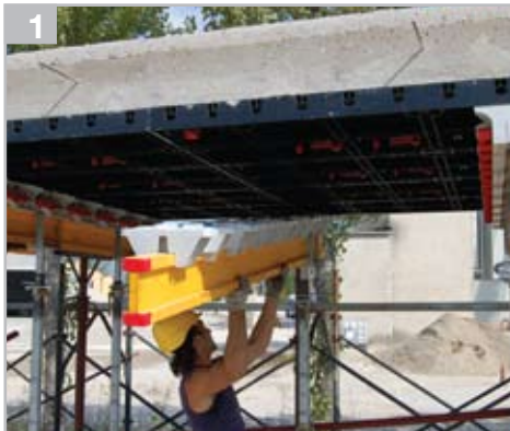
Zdjąć dźwigar w kształcie litery H
