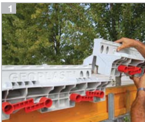
Ułożyć dźwigar Y połączony z klinem
