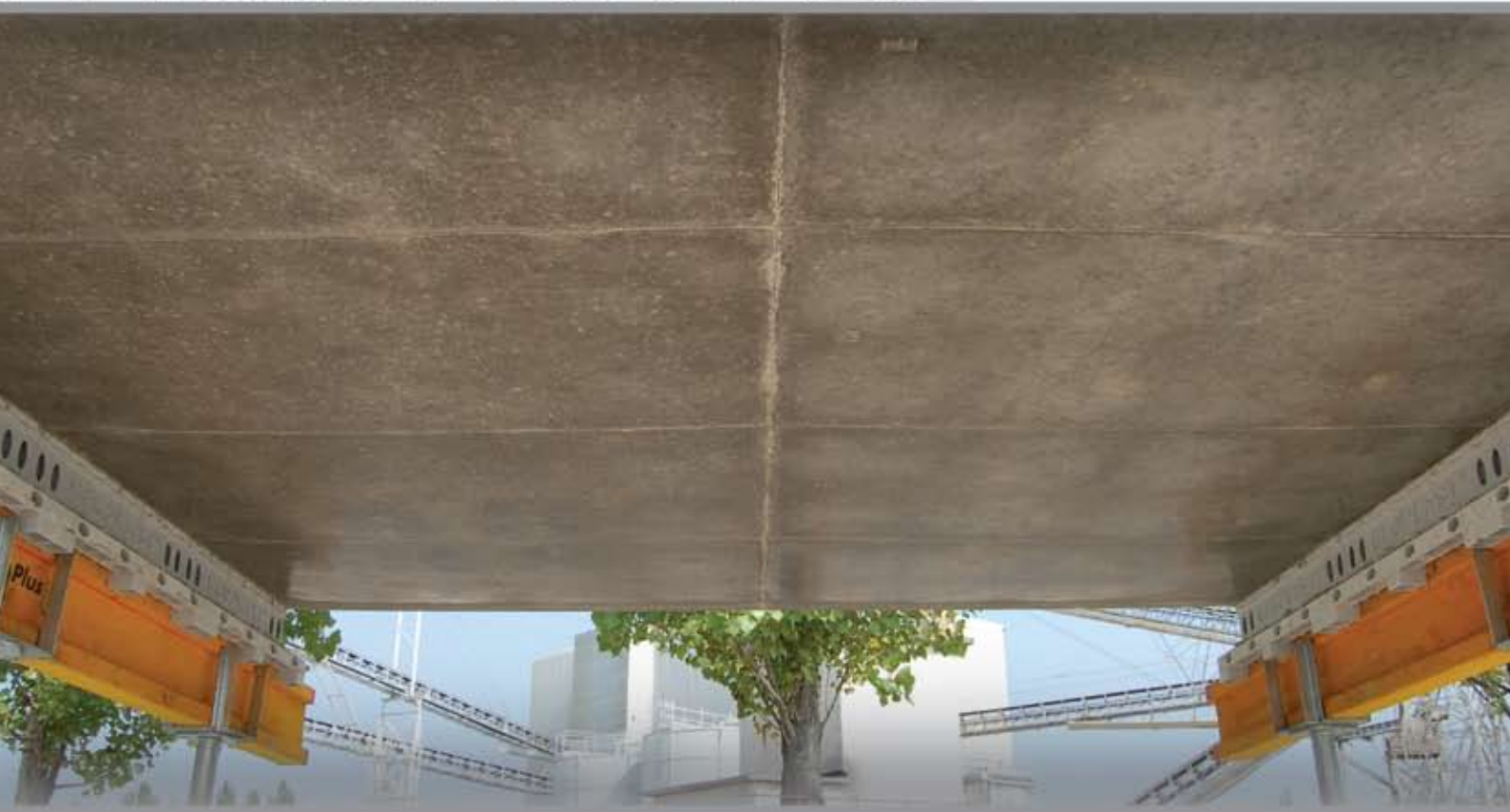
Szalunki stropowe z plastyku do wcześniejszego rozdeskowania
