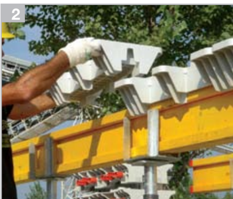
Ułożyć dźwigar w kształcie litery H
