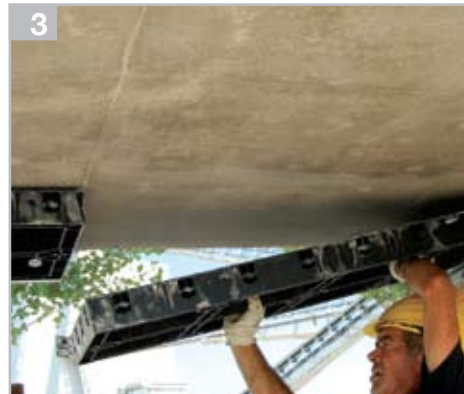
Wysunąć panele spod betonowania
