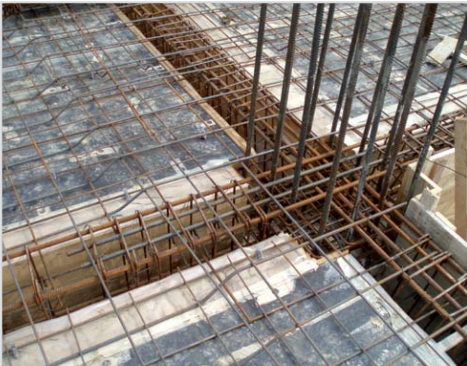
Betonowanie stropu i belek w jednej fazie
